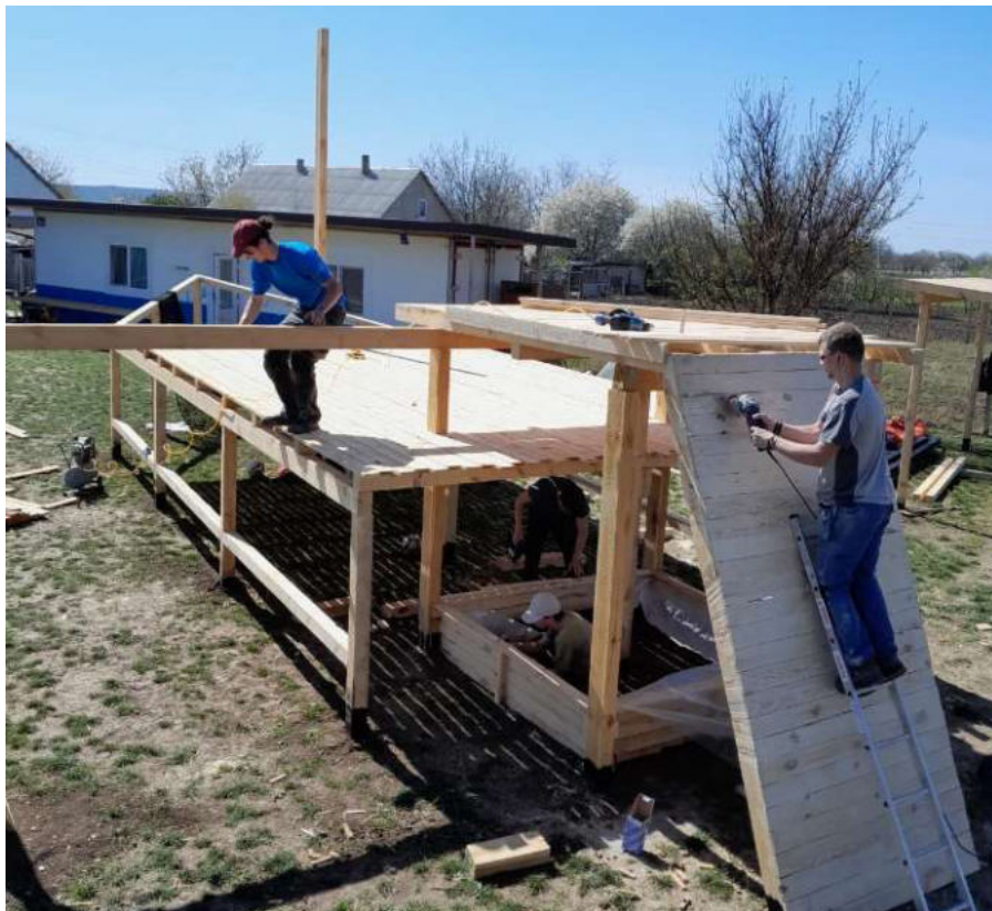
Balken für Schaukel, Bretter nageln, Sandkasten bauen, Kletterwand schleifen
