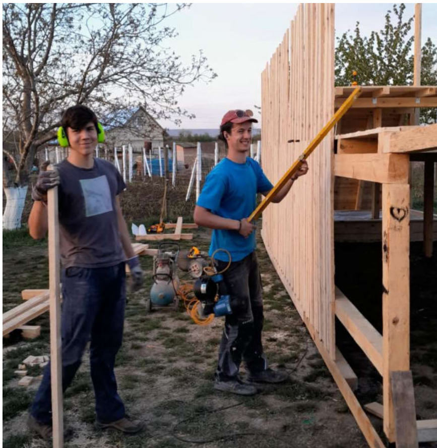
Alles im Lot? Zur Ausrüstung gehören auch Wasserwaage und Nagelpistole.
