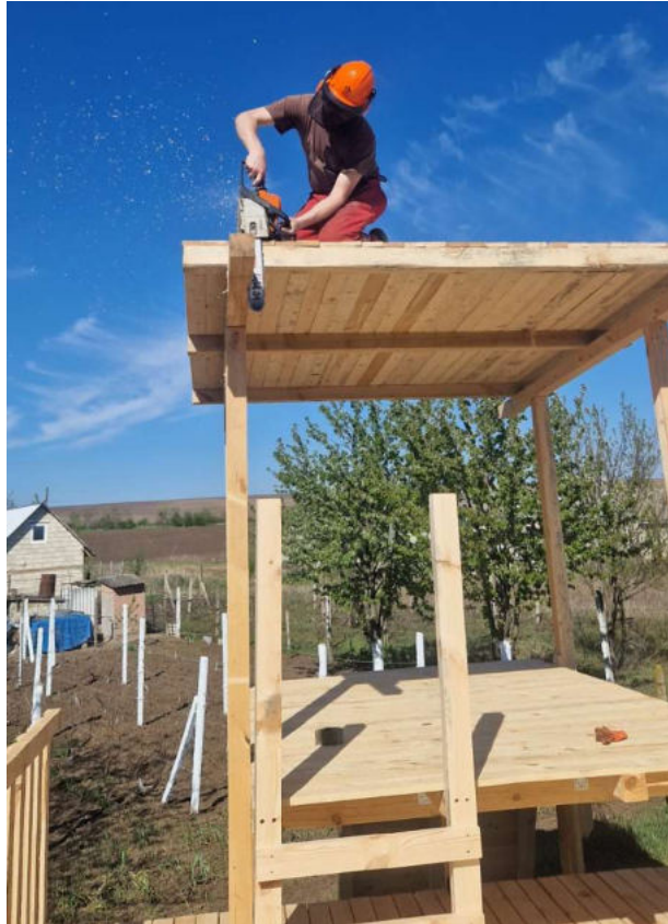
Die Motorsäge kommt oft zum Einsatz. Auf dem Turm entsteht später die Kapitänsbrücke mit Steuerrad.
