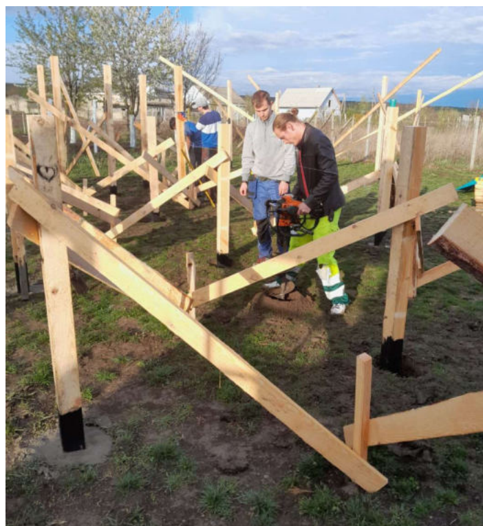
Löcher graben und Pfosten betonieren
